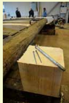
I Hallstahammar repareras slussportar för Strömsholms kanal. Läs hela reportaget på: www.vansterpartiet.se/medlemsrummet
